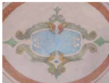
Medaglione: prima, durante e dopo il restauro
