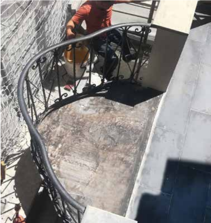
Il balconcino durante i lavori di restauro del 2021
